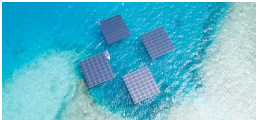
Solar Sea: Jede schwimmende Solarplattform ist 196 Quadratmeter groß und besteht aus 96 Solarpanelen
