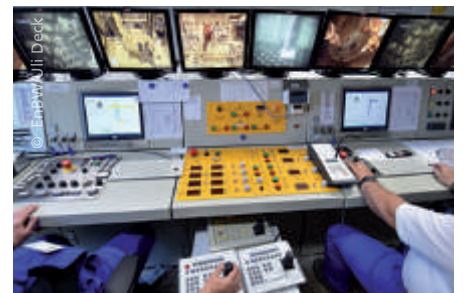
Fernbediente Zerlegung des Reaktors im Kernkraftwerk Obrigheim
