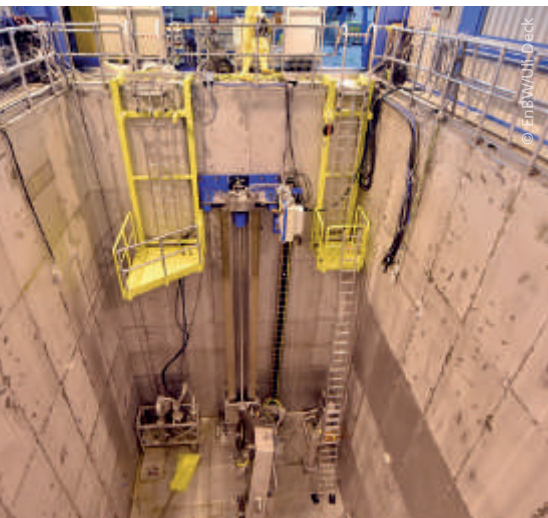
Kernkraftwerk Obrigheim: Das leere Brennelementlagerbecken wird während des Rückbaus zum Zerlegebereich
